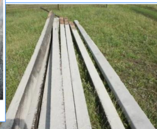
Демонтаж столбов освещения
