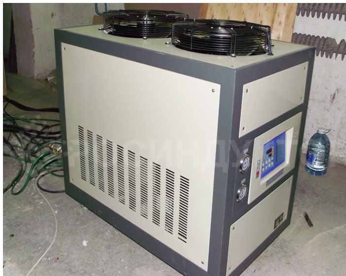
Рис.3 Чиллер для индукционных нагревателей и другого температурно нагруженного оборудования
