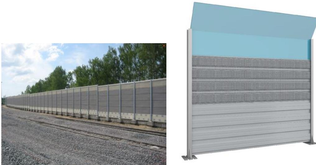
Рисунок 11 – Шумозащитных акустических экранов
