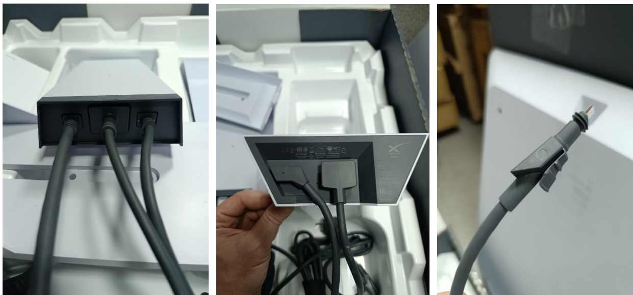
Рис.7-Проверка кабельных соединений
