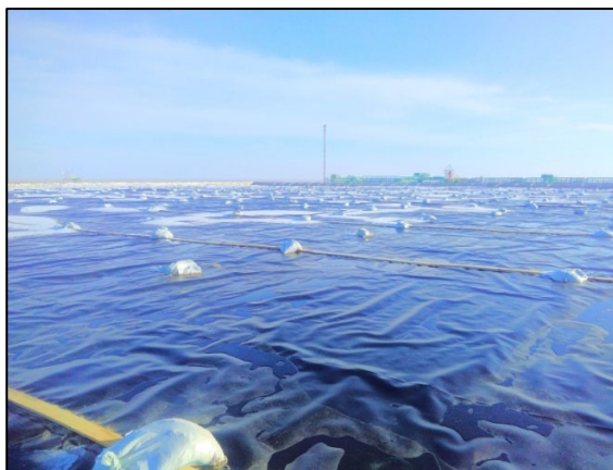
Фото 5.2 Покрытие верхней поверхности серного блока №2 геомембраной
