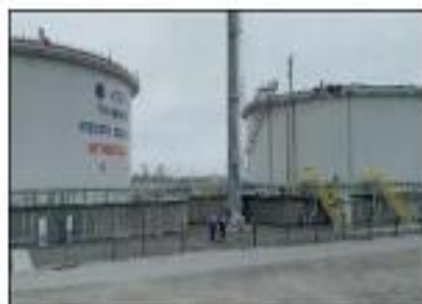
5-Сурет - 2023 жылы «Теңіз» МАС-та орнатылған қалқыма шатыры бар мұнай резервуарлары
