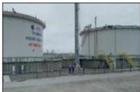
5-Сурет - 2023 жылы «Теңіз» МАС-та орнатылған қалқыма шатыры бар мұнай резервуарлары
