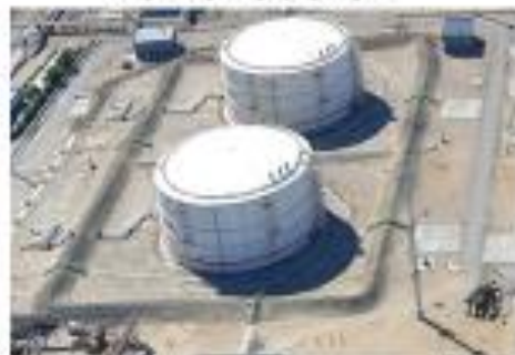
6-Сурет - Понтоны бар резервуарларды бөлшектеу
