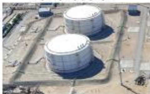
6-Сурет - Понтоны бар резервуарларды бөлшектеу
