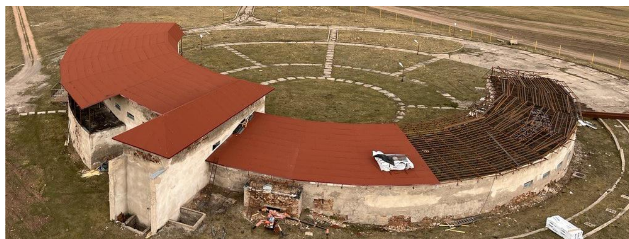
Установка в Гостинице новой крыши из мягкой черепицы. После завершения всех ремонтных работ, в Гостинице смогут размещаться до 60 человек
