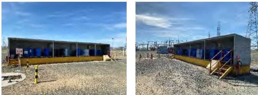
Фото 21 Площадка временного накопления отработанных масел на ТГТЭС-2
