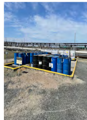
Фото 17 Площадка временного накопления жидких отходов химических материалов и отработанных масел на КТЛ (ХРХ)
