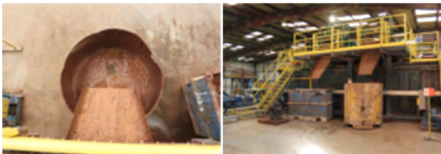
Фото 37 Процесс очистки бурового раствора на установках ENVIROCENTER
