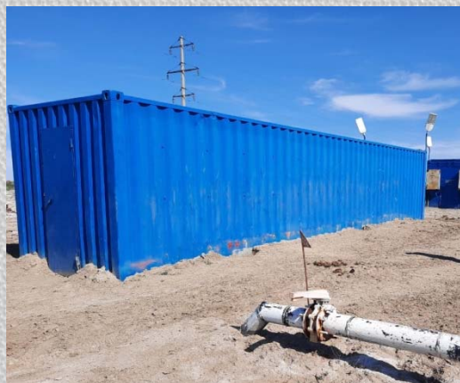
Сілтілеу және өнімді ерітінділерді ұңғымалардан жинайтын және тарататын қондырғылар
