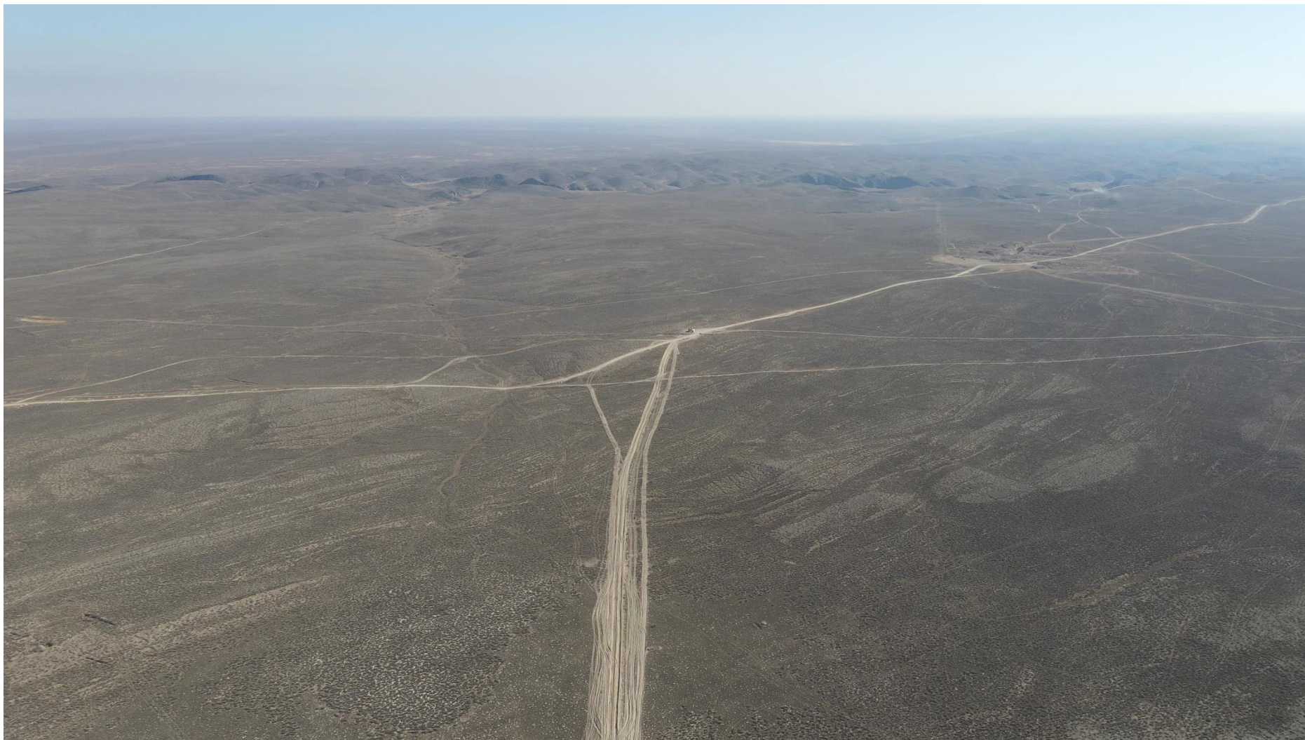
Фото 10. Конец проектируемого участка автодороги. Северный подъезд к месторождению Олимпийское.
