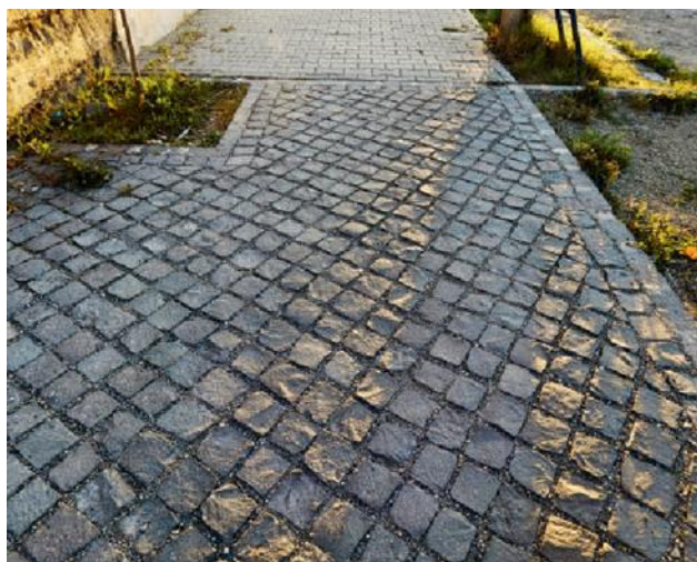
Рисунок 12 - Проницаемое мощение с заполнением швов гранитной крошкой
