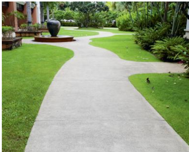
Рисунок 7 - Бетонное монолитное покрытие
