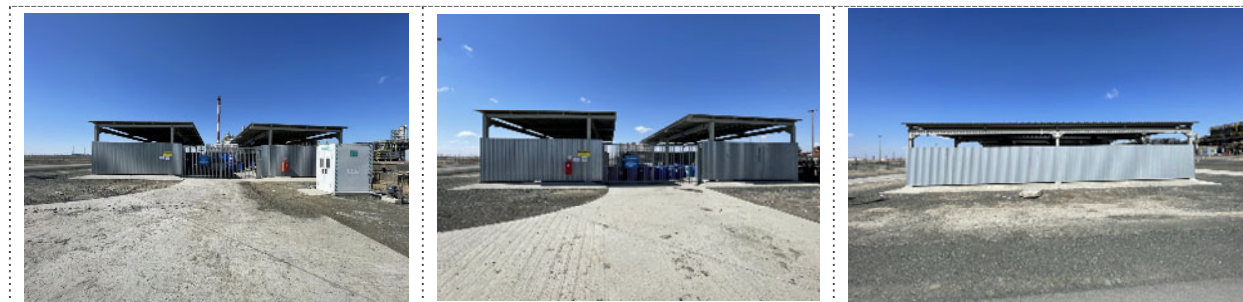
Фото 20 Площадка временного накопления жидких отходов химических материалов на ЗВП (ХРХ)
