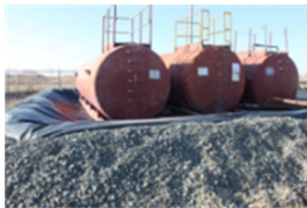
Фото 10 Площадка временного накопления отработанных масел на базе бурения
