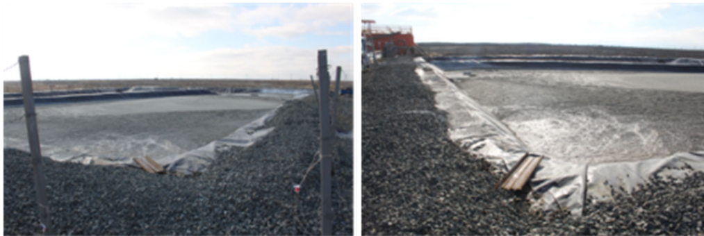
Фото 49 Общий вид участка хранения бурового шлама на водном основании
