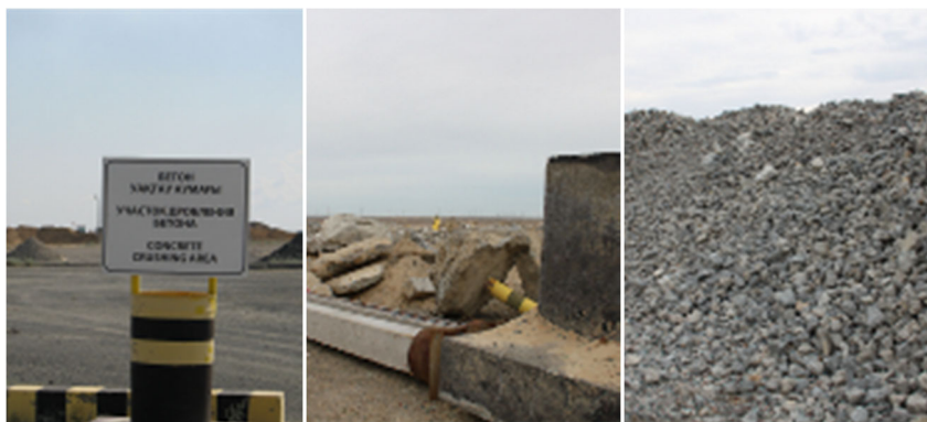
Фото 6 Площадка накопления бетона до и после крошения
