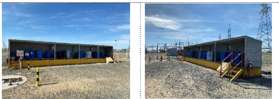
Фото 22 Площадка временного накопления отработанных масел на ТГТЭС-2
