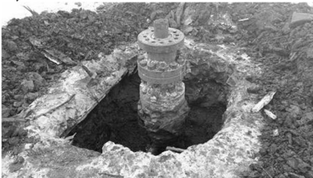
Рисунок 2. Текущее состояние устья скважины Южная-1
