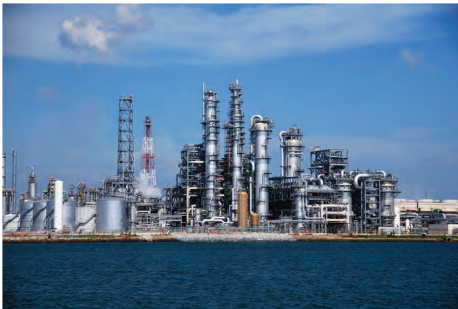
Нефтехимический комплекс в Сингапуре. Искусственный остров Джуронг занимает площадь около 32 км 2 . Нефтеперерабатывающие заводы острова перерабатывают 1 300 000 баррелей (210 000 м 3 ) сырой нефти в день
