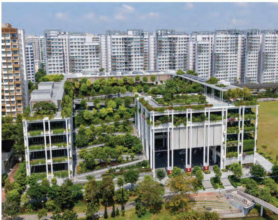
Районный центр нового поколения в Пунголе. В семиэтажном комплексе расположены поликлиника и детский сад, супермаркет, кафе и рестораны, круглосуточный фитнес-центр
