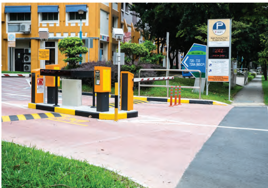
Общественные автопарковки, оснащённые электронной системой снятия средств. Транспортные средства регистрируются с помощью камер
