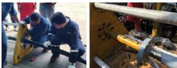
Рисунок 3.21 Оконечное обустройство с использованием полевой ковочно-обжимной машины
