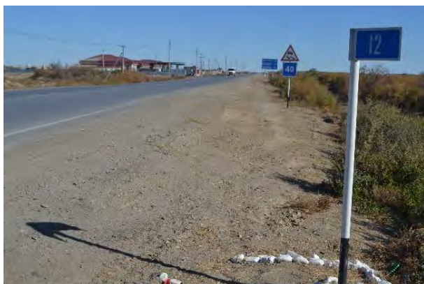
Фото 1. Начальная точка участка 12+000 – 24+600 км
