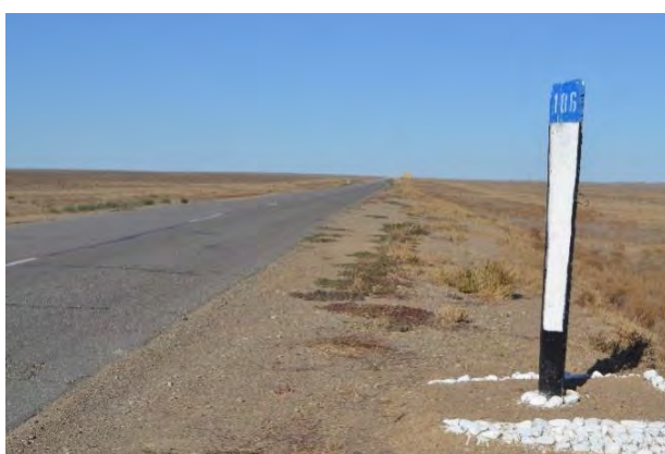
Фото 65. Начальная точка участка 186+000 – 216+000 км.
