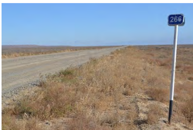
Фото 81. Начальная точка участка 266+000 – 314+000 км.
