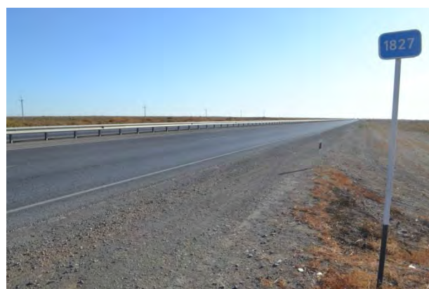
Фото 12. Начальная точка обхода г. Кызылорда. Километровый столб (1827 км)
