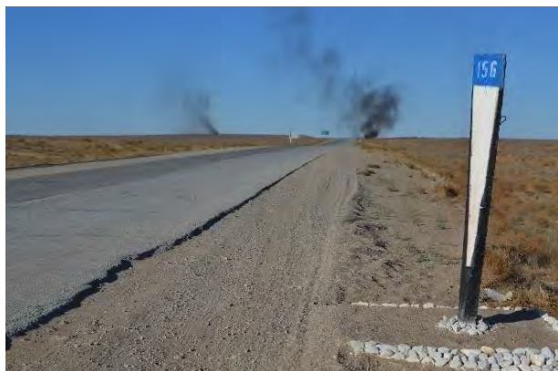
Фото 57. Начальная точка участка 156+000 – 186+000 км.
