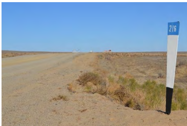
Фото 73. Начальная точка участка 216+000 – 266+000 км.
