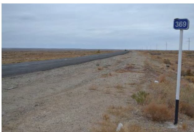
Фото 95. Начальная точка участка 369+000 – 424+000 км.
