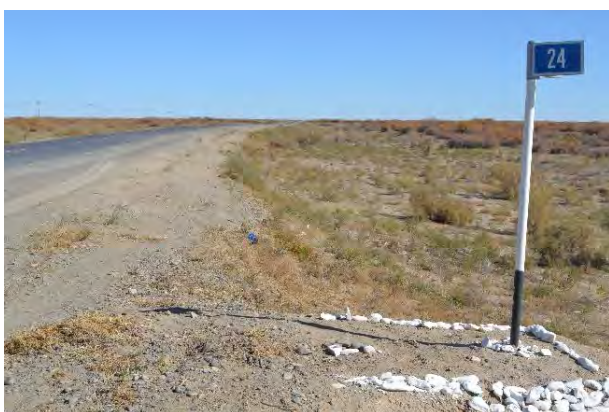
Фото 17. Начальная точка участка 24+600 - 76+000 км.
