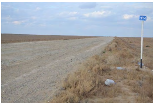
Фото 87. Начальная точка участка 314+000 – 369+000 км.
