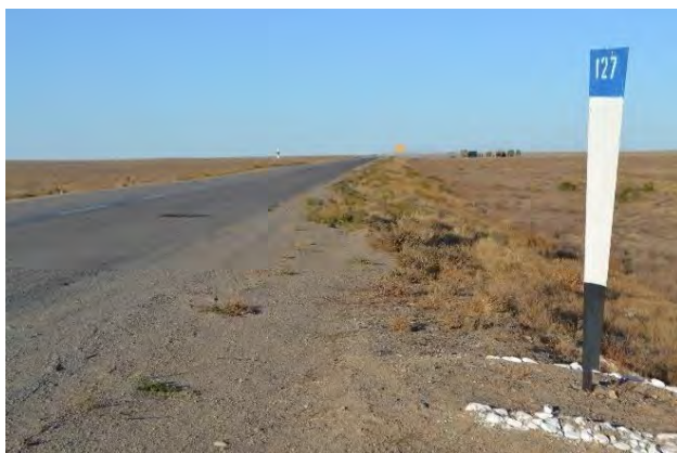
Фото 51. Начальная точка участка 127+000 – 156+000 км.
