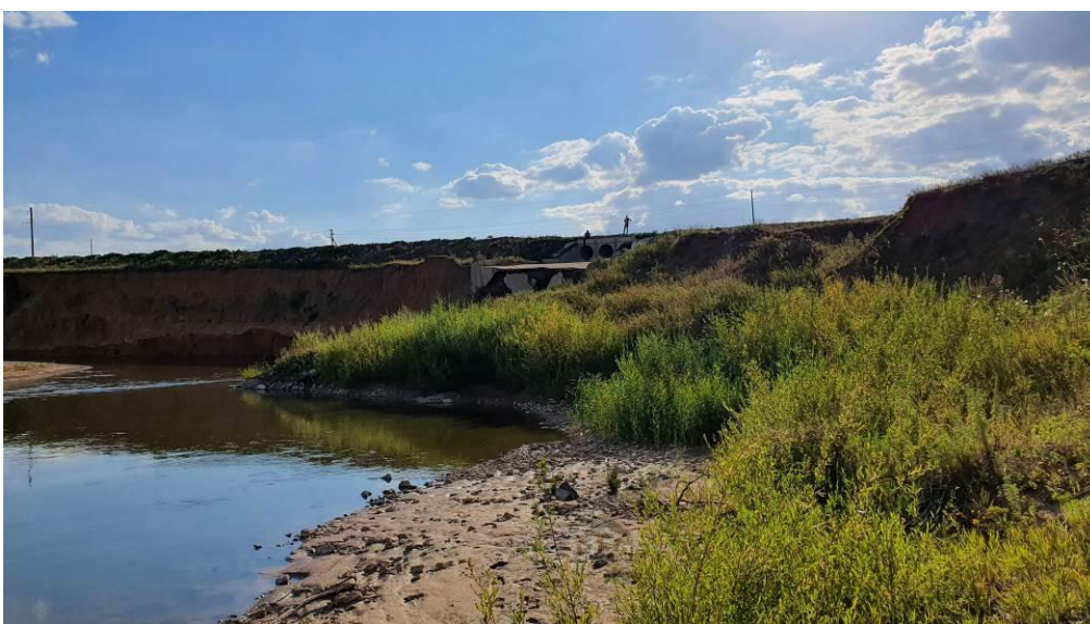
Рис. 4.12. Обрывистый берег реки у автомобильной дороги на ПК 127.
