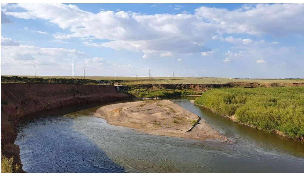
Рис. 4.13. Обрывистый берег реки у автомобильной дороги на ПК 127.
