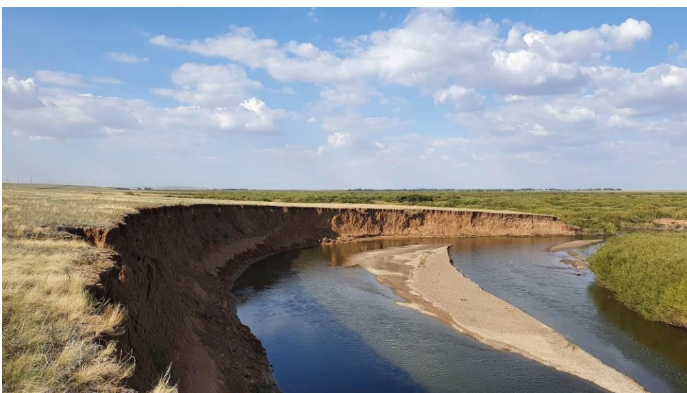
Рис. 4.15. Обрывистый берег реки у автомобильной дороги на ПК 119.
