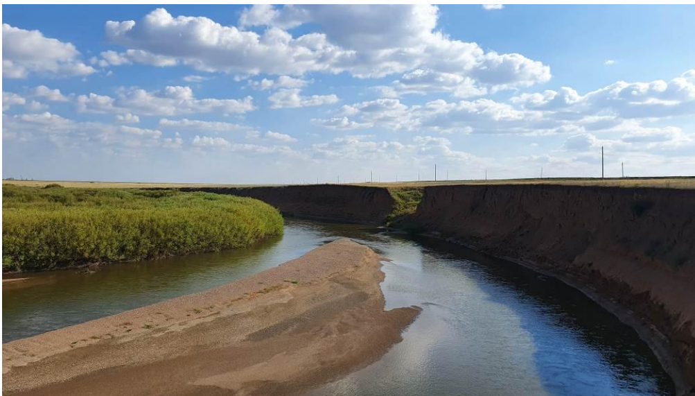
Рис. 4.14. Обрывистый берег реки и промоина у автомобильной дороги на ПК 119.
