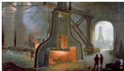
Рис. 1: Паровой молот Джеймса Несмита, 1839 г. 1
