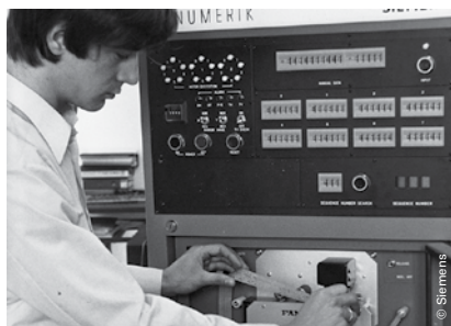
Рис. 3: Числовое программное управление с вводом данных с перфоленты (1970)
