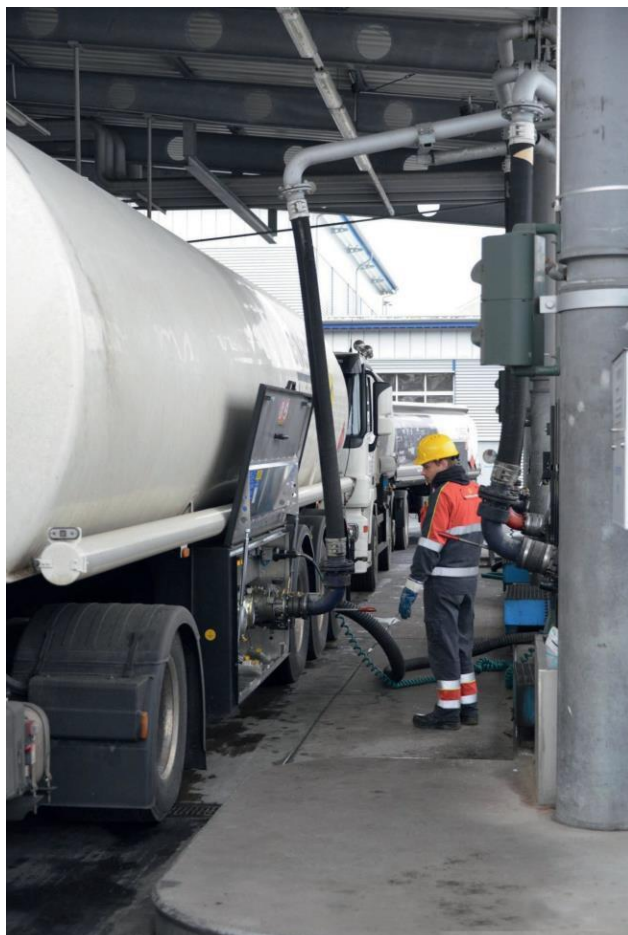
14.7 сурет Танкерді төменнен жүктеу Дереккөзі: Loadtec Engineered Systems Ltd
