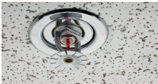
17.5 сурет Спринклерлік бас әрекет үстінде Дереккөзі: iStock.
