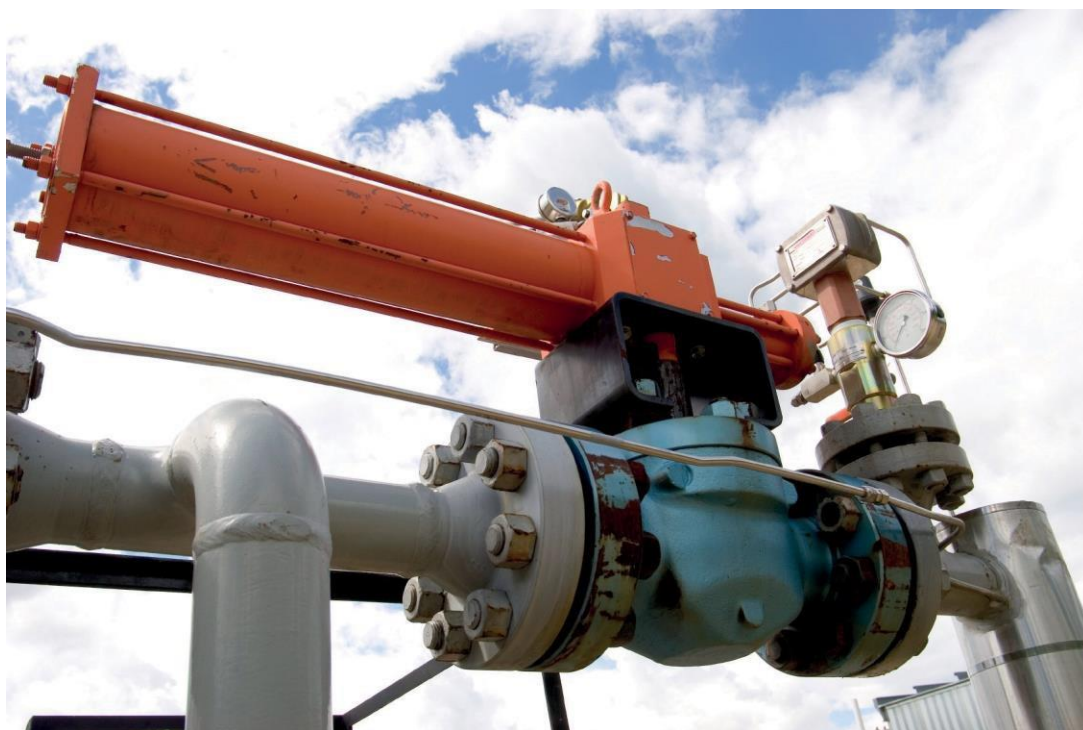
9.3-сурет Апаттық өшіру клапаны Дереккөзі: iStock.
