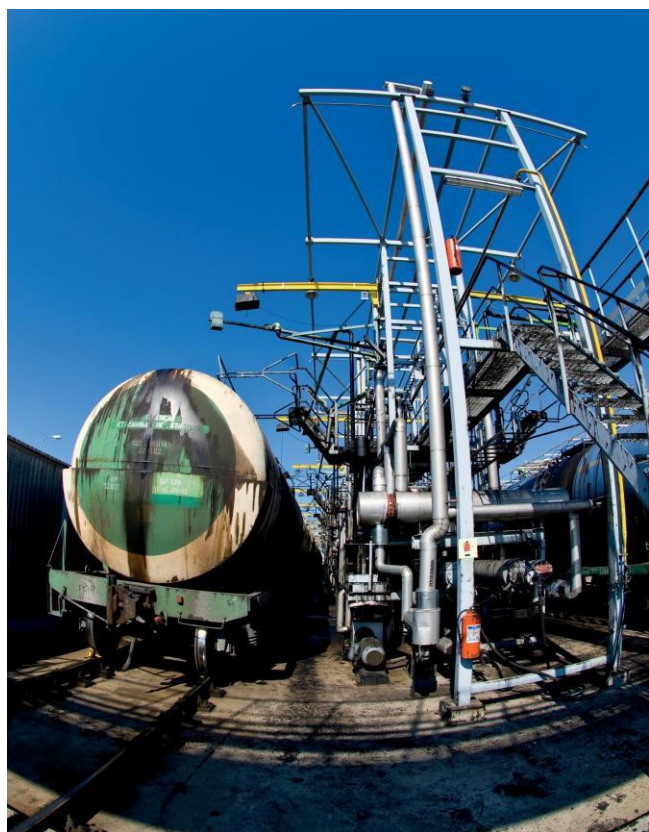
20.6-сур. теміржол цистерналарының тиеу құрылғылары Дереккөзі: Dreamstime.
