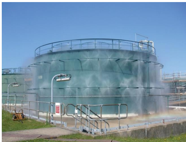
17.11-сурет Цистерналарды әрекетте бүрку жүйесі Дереккөзі: Мартин Уолл - Шаттерсток.
