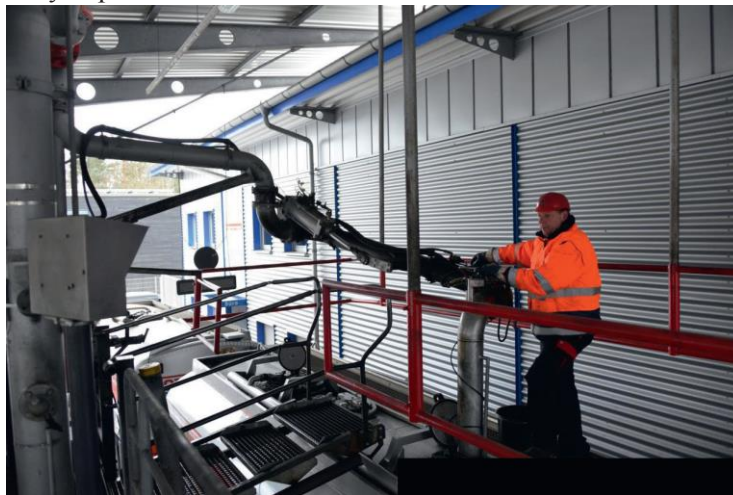
14.8 сурет танкердің Жоғарғы жүктелуі Дереккөзі: Loadtec Engineered Systems Ltd
