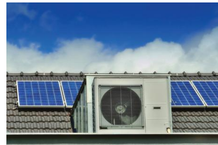
Сурет 3.8. Солтүстік жарты шарда орнатылған күн панельдері оңтүстікке қаратылуы керек
