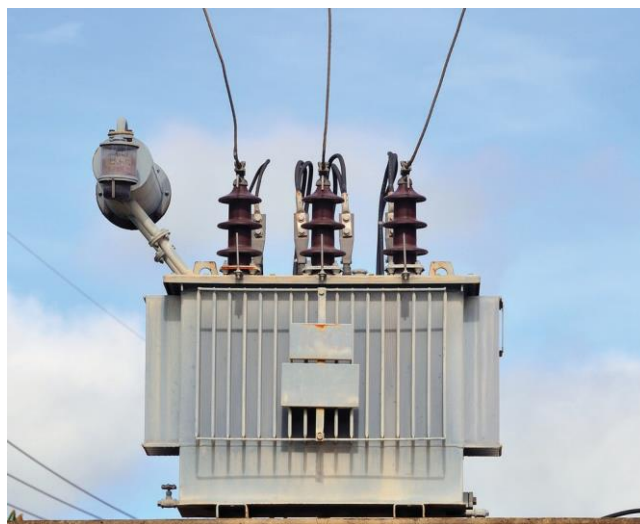
Сурет 2.19 Трансформаторлар электр энергиясын беру мен таратуда қолданылады. Электрліктер үшін Ом заңы өте маңызды болғанымен, бұл трансформаторларға
