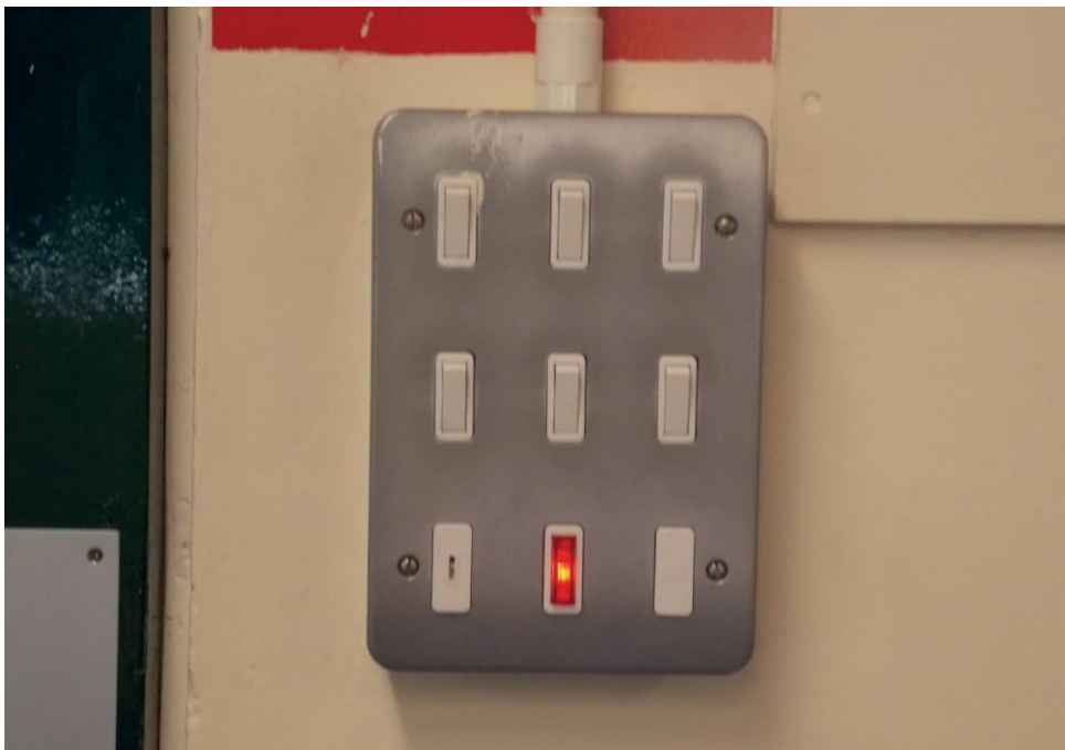
4.43-сурет Электр өткізгіш (металл) қондырғының барлық бөліктері ашық өткізгіш бөліктер деп аталады және оларды жерге қосу керек
