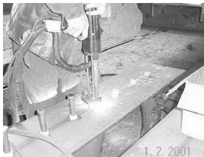
10.5 сурет. Істіктерді дәнекерлеп жабыстыру: қосылыс элементтерін дәнекерлеу—Боден-Шатонефтен алынған фотосурет
