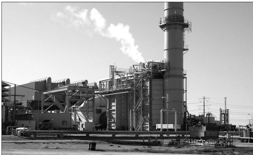
6.6: Мидлоттиан, штат Техас, США: одновальный блок GT24 с комбинированным циклом и однократным котлом-утилизатором. Один из шести блоков на площадке возле Далласа, штат Техас
