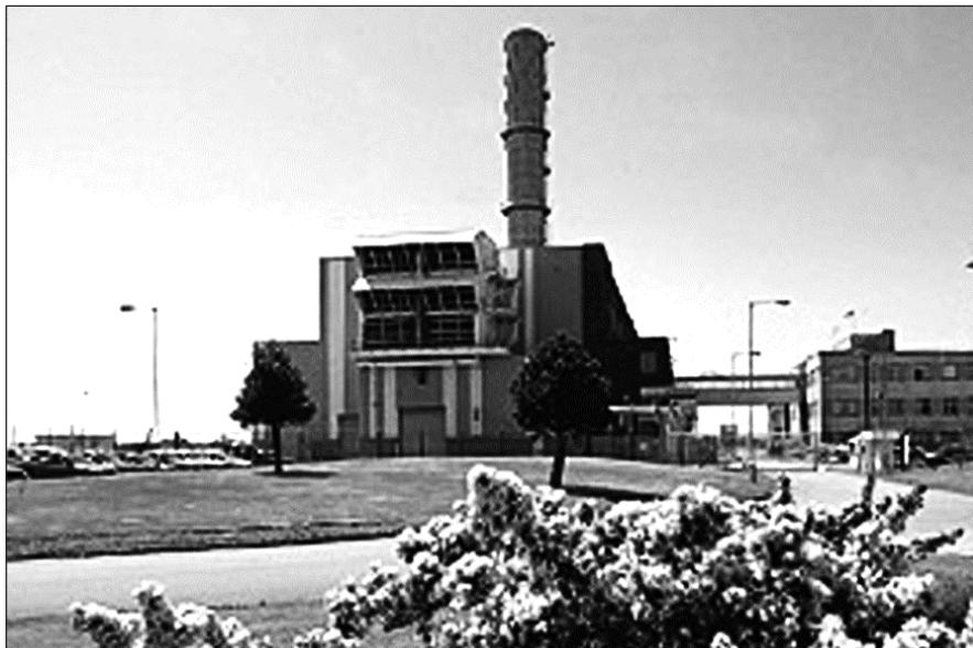
6.2: Рускот, Великобритания: электростанция с комбинированным циклом 220 МВт была построена в машинном зале бывшей электростанции мощностью 120 МВт около Барроу в Фернесс. (Фото предоставлено Centrica)
