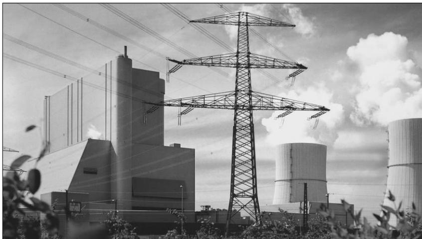
4.2: Schwarze Pumpe, Германия, электростанция сверхкритического нагрева мощностью 1600 МВт также отправляет паровые нагрузки на завод по производству брикетов и в местную сеть централизованного теплоснабжения. (Фото предоставлено Siemens)
