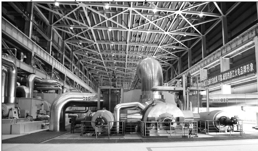
4.3: Чжэцзян, Китай: одна из четырех сверхкритических паровых турбин мощностью 1000 МВт на электростанции Юйхуань компании Huaneng Power Inc. (Фото предоставлено Siemens)
