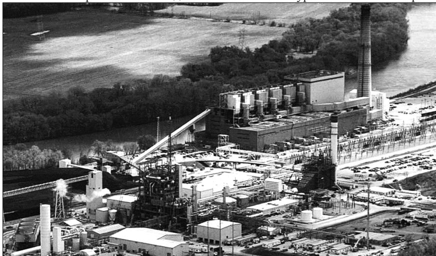
4.4: Река Вабаш, Индиана, США. IGCC мощностью 250 МВт был введен в эксплуатацию в 1997 году, и в отдельных кампаниях использовались угли с высоким содержанием серы и сырье для производства пертолеумового кокса. (Фото предоставлено PSL Energy)
