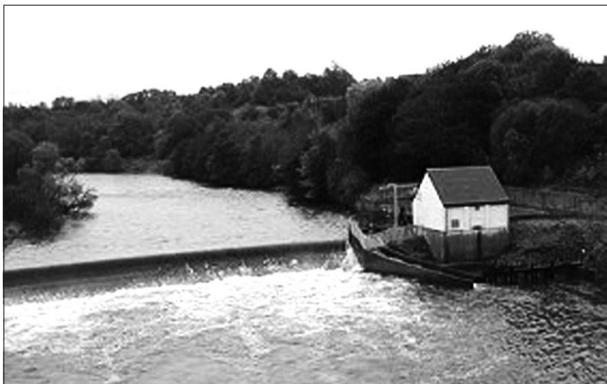
8.5: Блантайр, Шотландия: Гидравлическая станция RWE Npower мощностью 575 кВт в 15 км над Глазго на Клайде была построена на существующем водосливе. (Фото предоставлено Npower Renewables)
