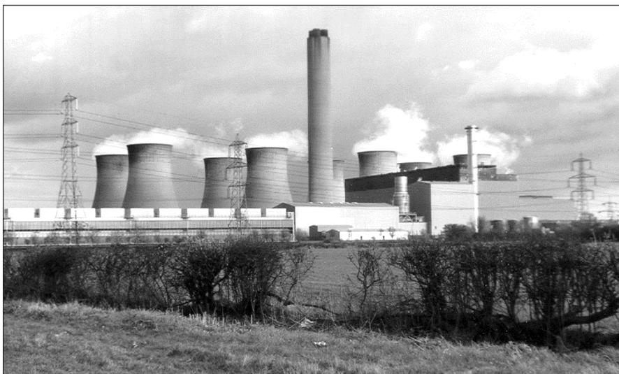
6.5 :: Коттам, Великобритания: комбинированный цикл 400 МВт с опытным котлом-утилизатором Benson. На заднем плане - угольная электростанция EdF Energy мощностью 2000 МВт
