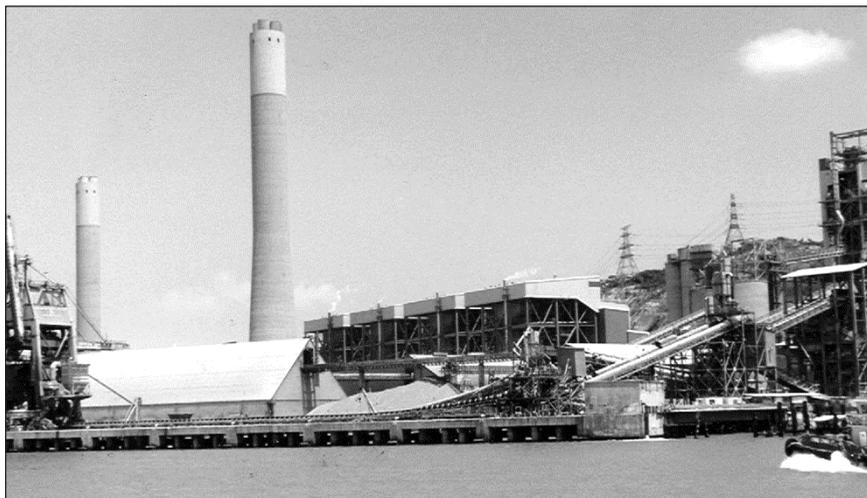
4.1: Гонконг: Станция Касл-Пик В с угольными установками мощностью 4 x 670 МВт оснащена системами SCR и FGD, что позволит ей продолжать работу после 2011 года
