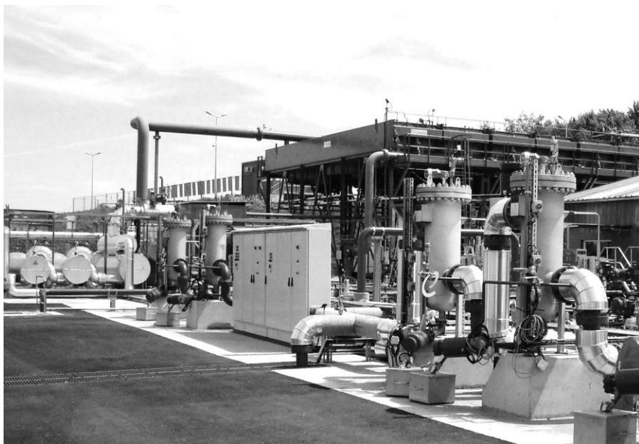
7.4: Сульц-сюр-Форе, Франция. Вода с температурой 2000 °С подается с 5000 м ниже площадки в теплообменник с изобутаном, приводящим турбину в движение. (Фото предоставлено GEIE EMC)
