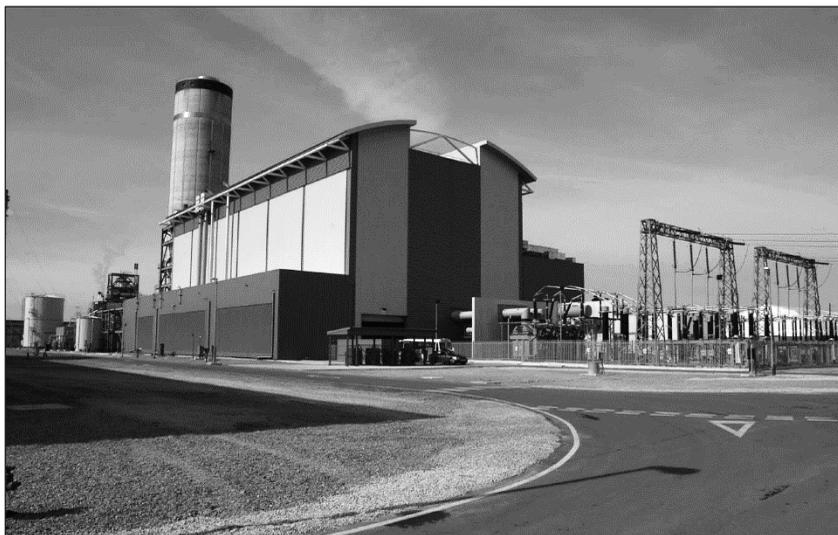
ованный цикл мощностью 480 МВт был первой газовой турбиной GE Frame 9H, которая была запущена в промышленную эксплуатацию в сентябре 2002 года
