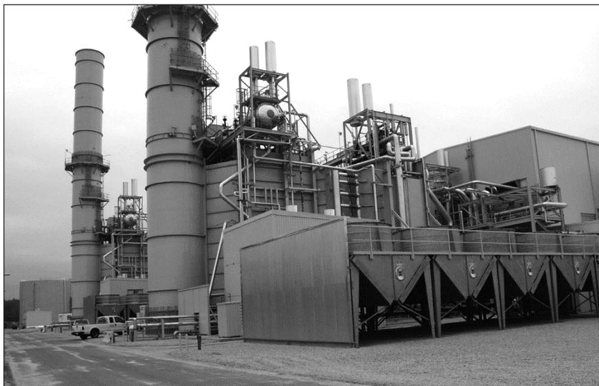
6.4: Блэкстоун, Массачусетс, США: стандартный одновальный блок GT24 от American National Power с котлами Venson, включая блоки SCR для сверхнизкого выхода NOx
