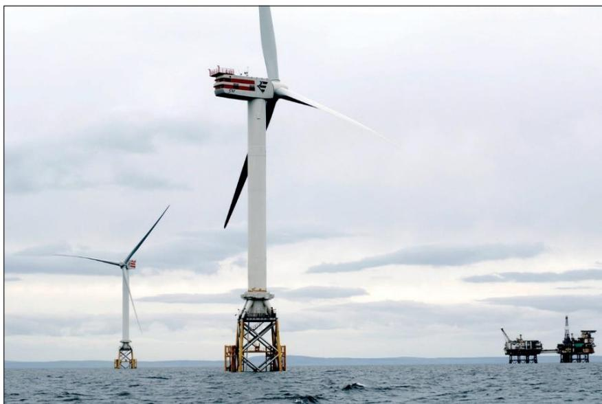
8.4: Два ветрогенератора мощностью 5 МВт из шотландских источников обеспечивают всю свою мощность на нефтяной платформе Talisman, показанной справа. (Фото предоставлено RE Power Systems)
