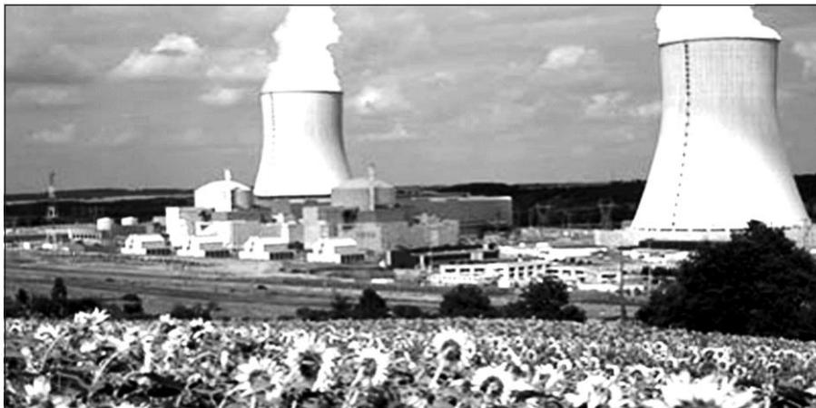
5.4: Сиво, Франция. Станция EdF была первой с реактором N4 мощностью 1400 МВт, из которого был разработан EPR. (Фото предоставлено АЭС Арева)
