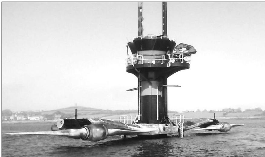
8.8: Великобритания: коммерческий прототип Seagen с генераторами, поднятыми из воды, как и для технического обслуживания. (Фото предоставлено Marine Current Turbines)
