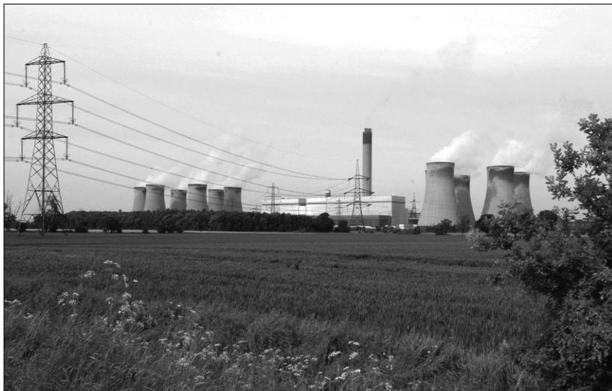
4.7: Дракс, Великобритания. Эта электростанция на 4000 МВт, работающая на угле, в 2009 году будет совместно использовать 10% твердую биомассу наряду с модернизацией турбины для сокращения выбросов парниковых газов
