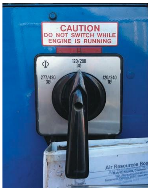
Сурет 7.19 Үш фазалы генератордағы кернеуді таңдау ауыстырып қосқышы генераторды іске қосар алдында орнатылуы тиіс және генератордың жұмысы кезінде ешқашан өзгермеуі тиіс.
