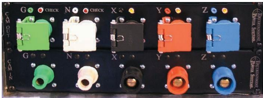
12.14-сурет. Cam-Lok панельді қосқыштары. Шығару коннекторларының серіппелі қақпақтарына назар аударыңыз (жоғарғы).
