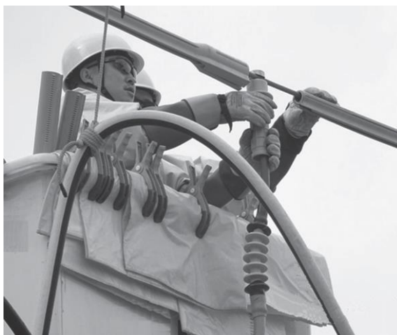
Рис. 9.25 Подсоединение кабельных выводов без нагрузки подъемным устройством с изолирующим звеном.
