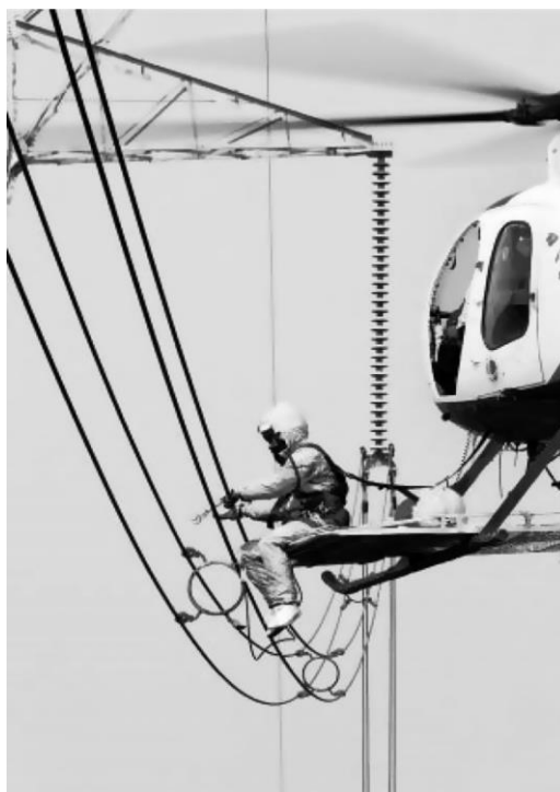
Рис. 1.5 Производство работ под напряжением с уравниванием потенциалов с применением вертолета.
