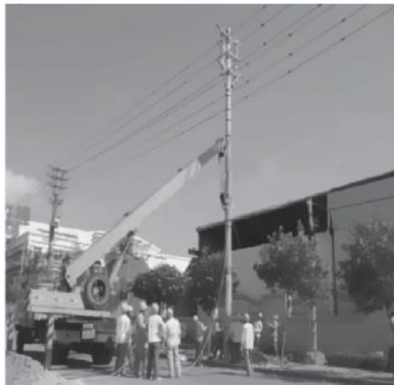
Рис. 7.10 Установка двухцепной подвесной опоры. (a) установки изолирующих покрытий; (b) подъем и установка опоры в нужное место; (c) закрепление проводов.
