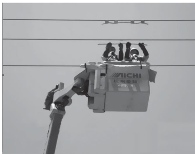
Рис. 7.1 Ремонт проводов.
