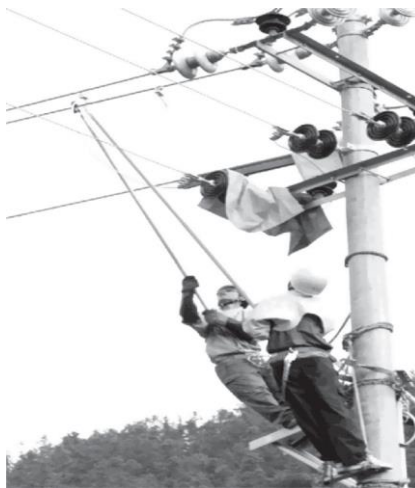
Рис. 7.4 Подключение обходных перемычек без нагрузки с помощью изолирующей ручной штанги
