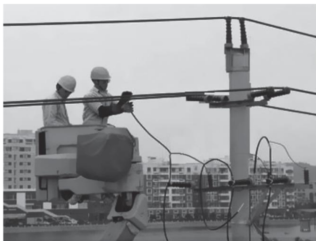
Рис. 7.2 Подключение обходных перемычек без нагрузки под напряжением при помощи подъемного устройства с изолирующим звеном.
