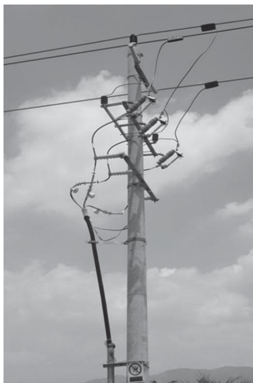
Рис. 2.18 Схема установки предохранителей.
