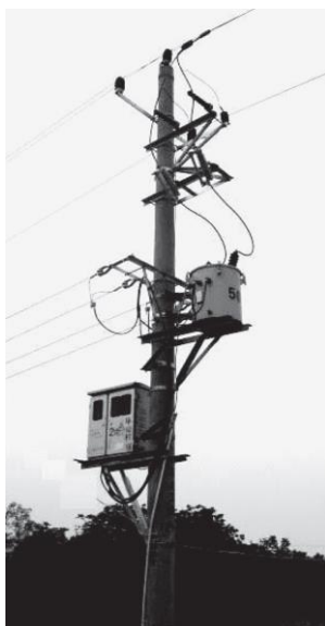
Рис. 2.14 Схема распределительных трансформаторных платформ. (a) трансформаторная платформа из одной опоры; (b) трансформаторная платформа из двух опор.
