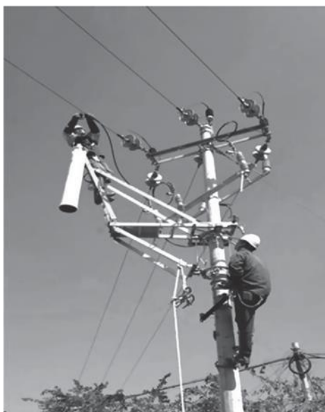
Рис. 7.3 Подключение обходных перемычек с помощью изолирующей платформы.
