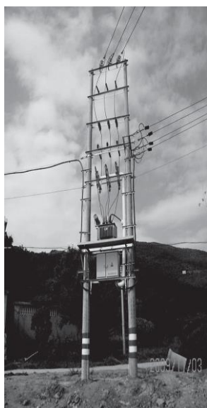
Рис. 2.14 Схема распределительных трансформаторных платформ. (a) трансформаторная платформа из одной опоры; (b) трансформаторная платформа из двух опор.
