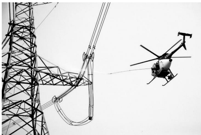
Рис. 1.4 Обмыв изоляторов под напряжением с помощью вертолета.
