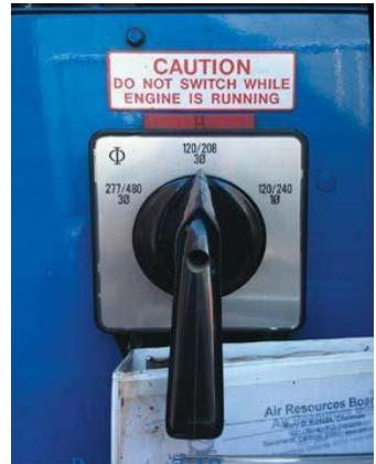
Рисунок 7.19 Переключатель выбора напряжения тока на трехфазном генераторе должен быть установлен перед начинать генератор и он никогда не должен быть изменен пока генератор работает.
