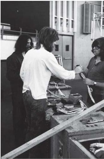
Рисунок А1.1 чип- Монк (в центре) объясняет Рою Лэмбу (справа) что ему все еще нужно связать пять отдельных проводников вместе. Они строят пользовательские кабельные сборки с помощью АА #провода 12awg однопроводникового о кабеля, гр. 1970.
