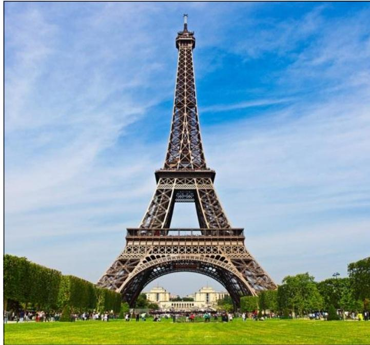
РИСУНОК 4-2: Эйфелева башня построена из 7300 тонн кованого железа, класса низкоуглеродистого железа, который, как правило, вдальбливают в форму в горячем виде, а не отливают.
