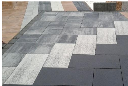
ПОКРЫТИЯ ИЗ БЕТОННЫХ ПЛИТ
